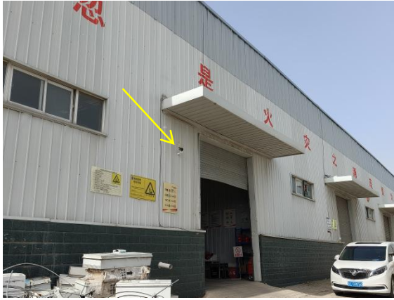
项目库房外貌、监控探头
