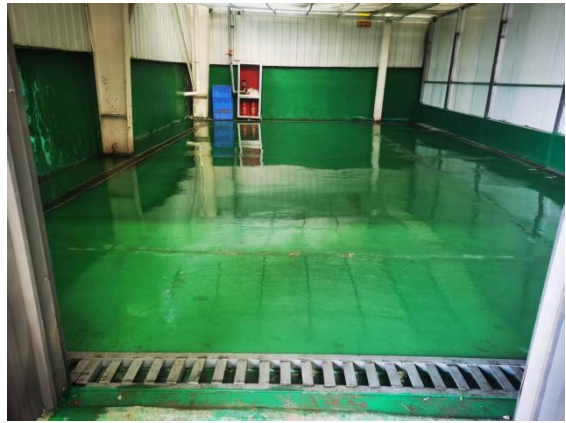
危废间全貌（施工结束）
